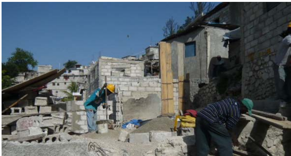
Une maison en réparation selon la formation et les normes de construction enseignées par Build Change, 22 juin 2011. Photo fournie par la délégation.
